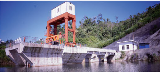
水电站进水口工程 The Intake
